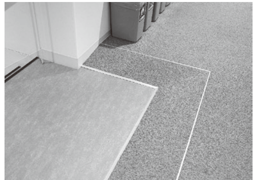
Fig.1 ラーニング commons のスロープ
