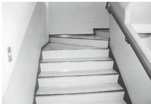
Fig.10 サークル棟階段
