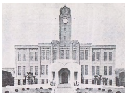
図11 復旧工事完成時の時計台〔文献41〕
